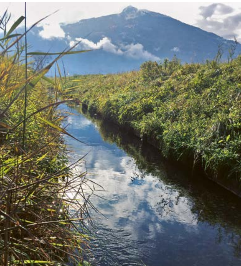
Le canal Bras-Neuf est contaminé par des métaux, des HAP et des PCB.
